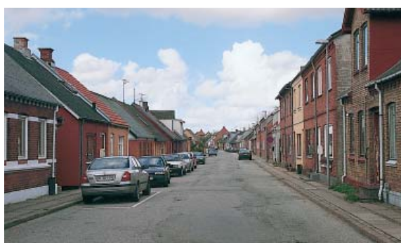
3. Den sammenbyggede bebyggelse i Markedsgade forstærker oplevelsen af det varierede gaderum.
