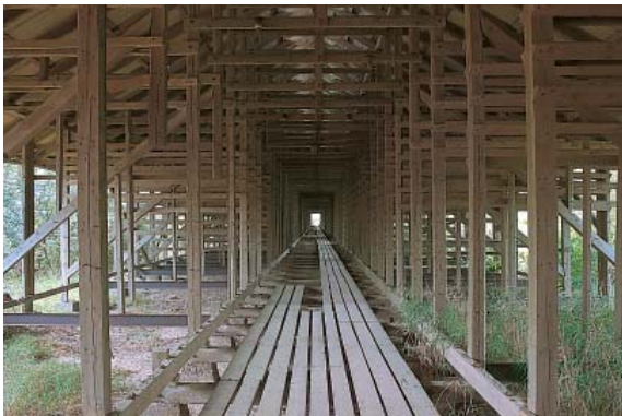
1. Den gamle tørrelades trækonstruktion.
